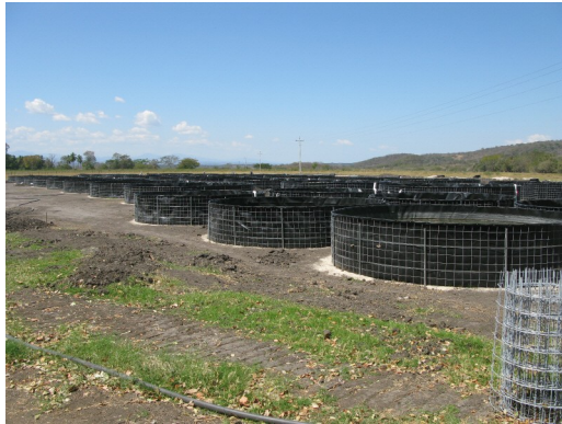
< 농장에 건설 중인 티라피아 양식 탱크 >
